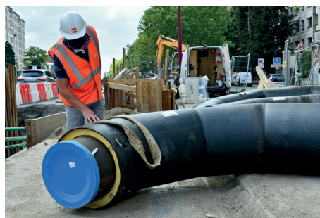
Création du réseau de chaleur urbaine de Lille.
