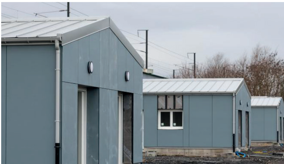
Constructions et aménagements de maisons à ossature bois.
