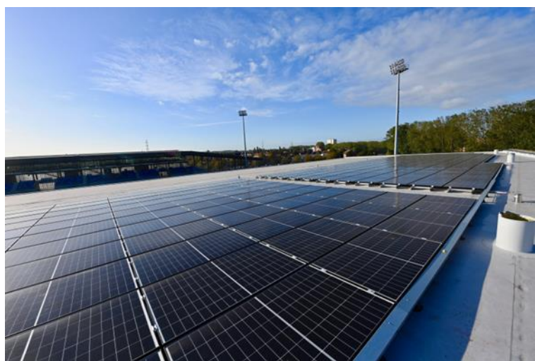
ENERGIE RENOUVELABLE – Pose de panneaux photovoltaïques (Stade TRIBUT - Dunkerque)
