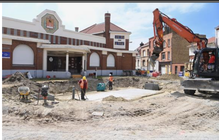
EAU - Enfouissement d'une cuve de récupération des eaux de pluie (école élémentaire de la mer – Malo)
