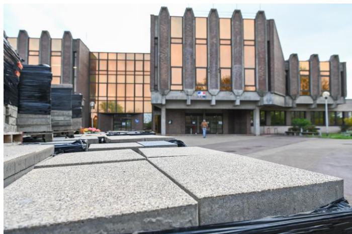
REEMPLOI – Récupération des dalles de la digue de Malo-les-Bains pour aménager le nouveau parvis de l'hôtel de ville de Leffrinckoucke
