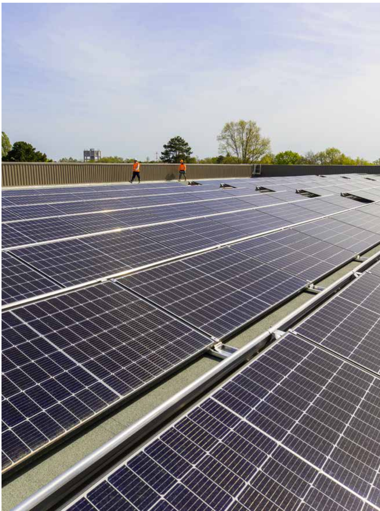
↑ TOIT DU COLLÈGE ANDRÉE CHEDID, AU HAILLAN
